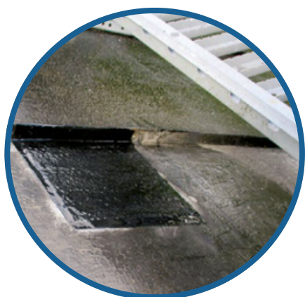
Reiät sekä kulkusilta- ja lumiestekiinnitykset
