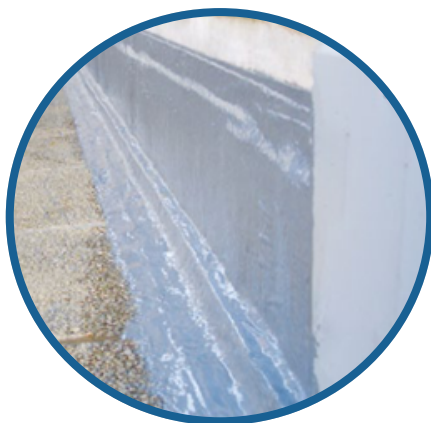
Seinäliitokset ja piippujen juuret
